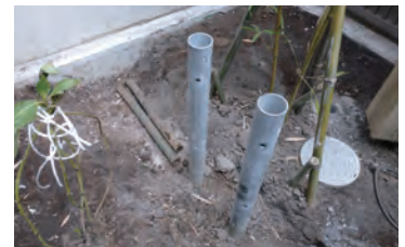
ピン工法改修時の様子
